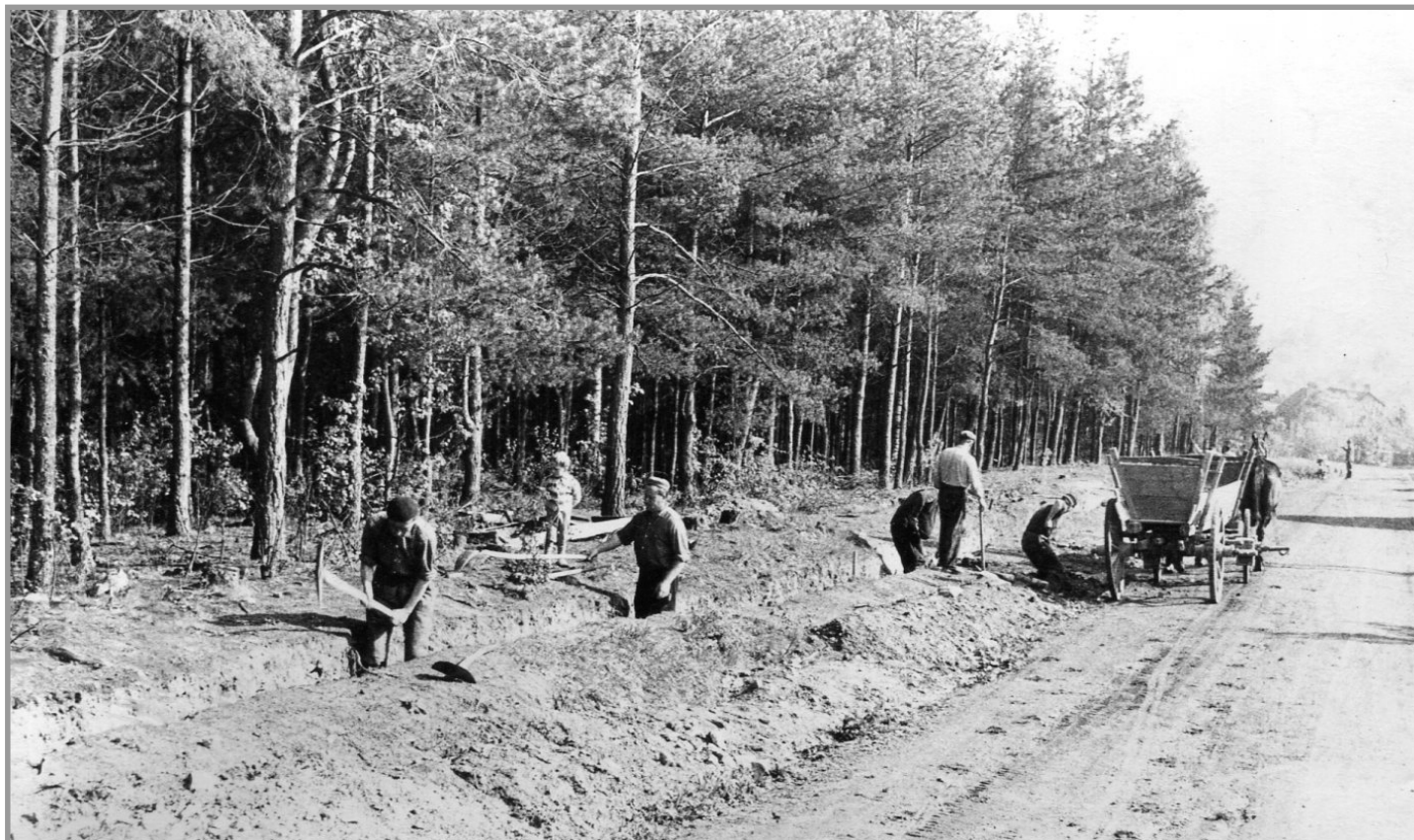
Obecnice, Nové Chalupy - pokládka trubek při zavadění prvního vodovodu (výstavba započala v roce 1959).
