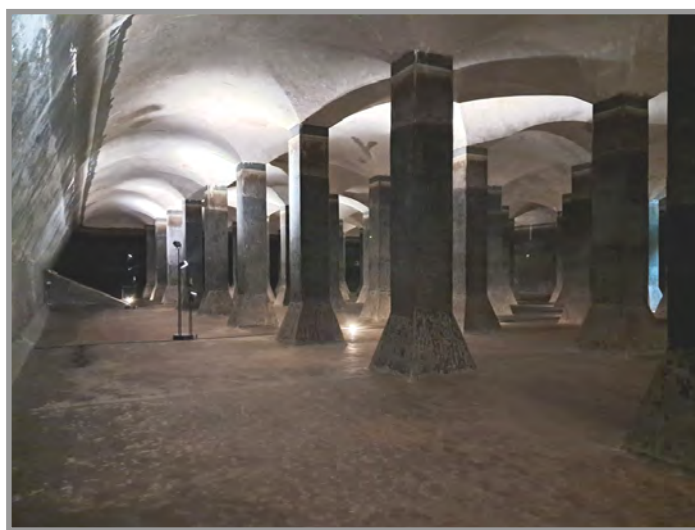
Vodojem z roku 1917
