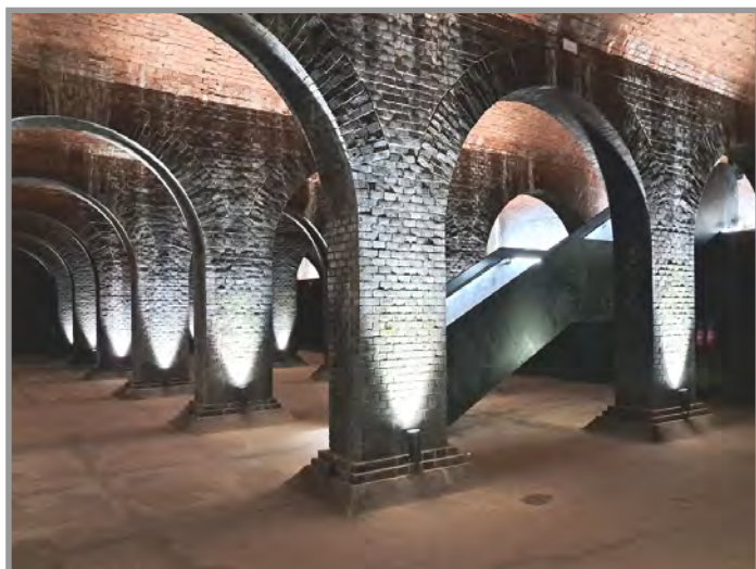
Vodojem z roku 1894
