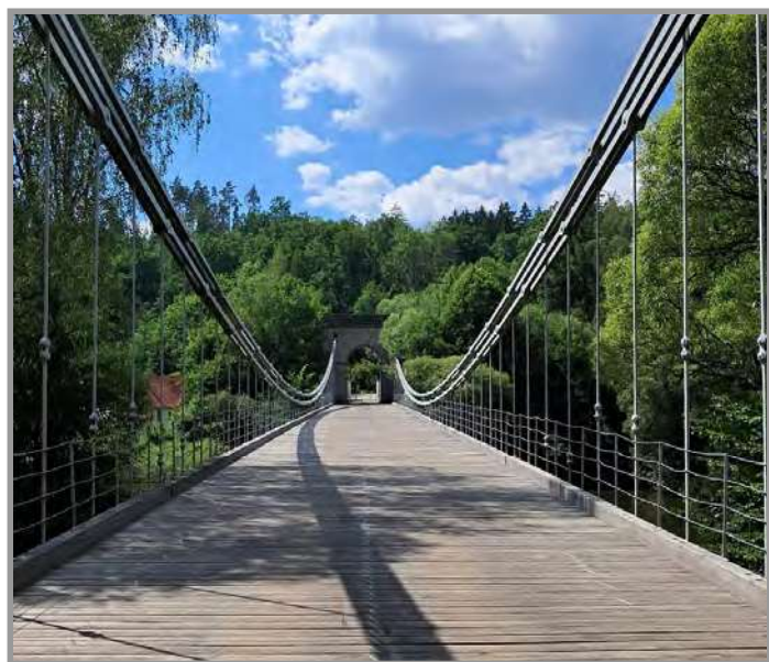
Nosnou konstrukci tvoří čtyři řetězy uspořádané do dvou dvojic
