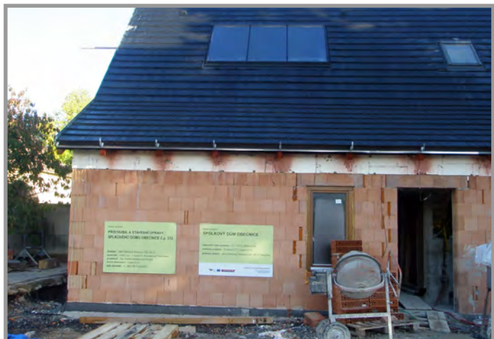
Rekonstrukce spolkového domu v Obecnici
