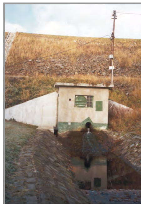
Výpust' pod hrází
