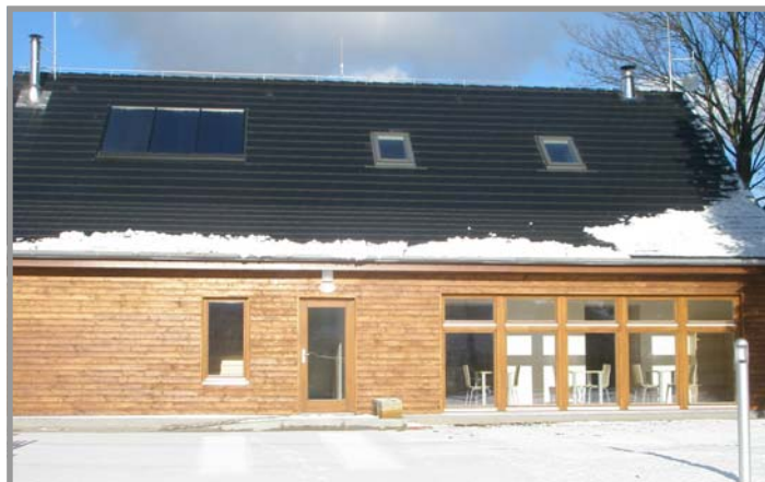
Dokončená rekonstrukce bývalé klubovny (známé jako Kozlárna)
