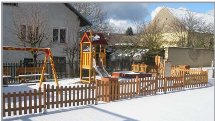
Celková rekonstrukce společenského domu zahrnovala také úpravu venkovního okolí
